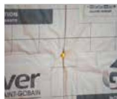
Embrochage de l'isolant GR 32 sur la tige de l'**Appui Optima<sub>2</sub>**
