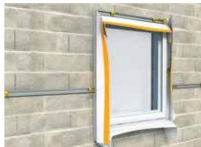
Positionnement de la membrane Xtra Band sur le pourtour de la fenetre après pose de l'isolant GR32
