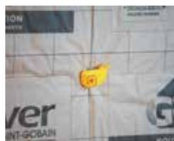
Pose de la clé d'**Appui Optima<sub>2</sub>** en position ouverte
