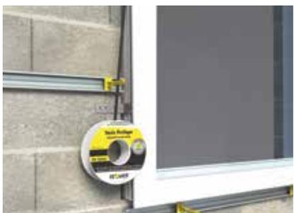
Collage de la membrane Xtra Band avec adhésif spécial Vario Protape en entourage de fenetre (alternative au collage avec mastic Vario double fit)
