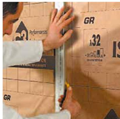
Mise en place des fourrures verticales **Fourrure Optima 240** et verrouillage de clés d'**Appui Optima<sub>2</sub>**
