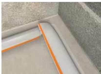
Pliage de la bande de membranes Vario® Xtra Band en angle rentrant
