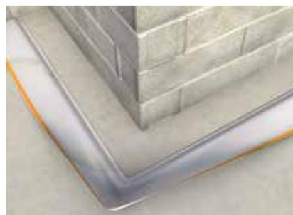
Pliage de la bande de membranes Vario® Xtra Band en angle sortant
