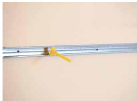
Étape pose des tiges d'**Appui Optima<sub>2</sub>** sur la fourrure horizontale murale **Fourrure Optima**
