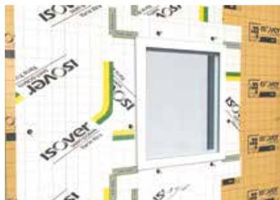
Liaison de la bande de membrane Vario® Xtra avec Vario® Xtra Band en entourage de fenêtre
