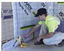
l'étanchéité à l'air en partie basse de mur: Liaison étanche de la membrane et des bandes de membrane **Vario® Xtra**
