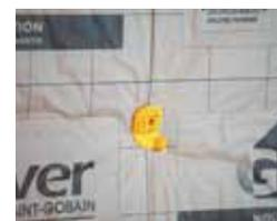
Verrouillage provisoire de la clé d'**Appui Optima<sub>2</sub>** par rotation quart de tour
