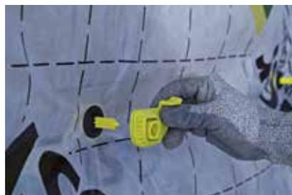
La clé d'appui Optima<sub>2</sub> peut être posée de façon provisoire avant la pose de l'ossature verticale
