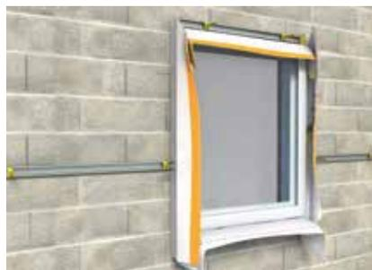
Mise en place de la membrane Xtra Band sur le pourtour de la fenetre
