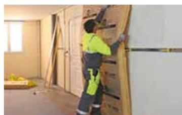
Mise en œuvre de l'isolant GR32 et embrochage sur les tiges d'**Appuis Optima<sub>2</sub>**
