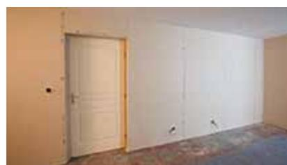
Parement plaque de plâtre vissé sur les **Fourrures Optima 240**
