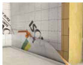
Liaison de la bande de membrane **Vario® Xtra** avec **Vario® Xtra Band** avec double face intégré en partie basse de mur
