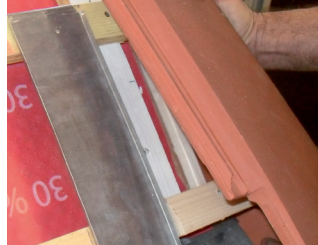
Rabat droit. Mettre une cale sous le rabat au nez pour l'ajuster à la hauteur de la tuile d'aération basse. Prolonger l'emboîtement du rabat à la gouttière par un couloir. Rogner le dessus de la baguette d'emboîtement de la tuile d'aération basse pour que celle-ci s'emboîte parfaitement.
