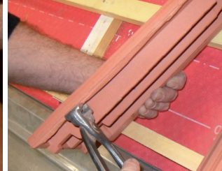
Rabat droit. Mettre une cale sous le rabat au nez pour l'ajuster à la hauteur de la tuile d'aération basse. Prolonger l'emboîtement du rabat à la gouttière par un couloir. Rogner le dessus de la baguette d'emboîtement de la tuile d'aération basse pour que celle-ci s'emboîte parfaitement.
