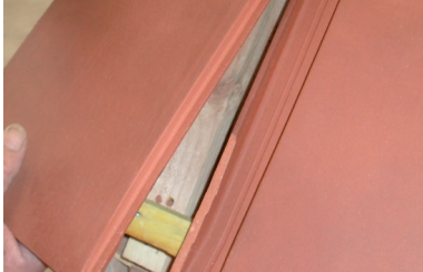
Rabat gauche. Rogner le dessus de la baguette d'emboîtement de la tuile d'aération basse pour que le rabat gauche s'emboîte parfaitement.
